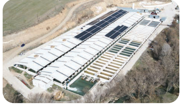
Kayseri Gümüşdoğa / 900 kWp
