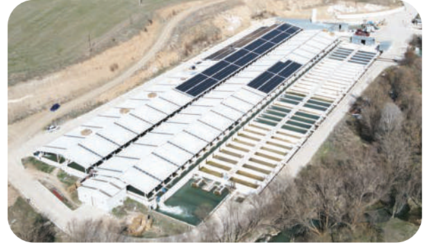
Kayseri Gümüşdoğa / 900 kWp
